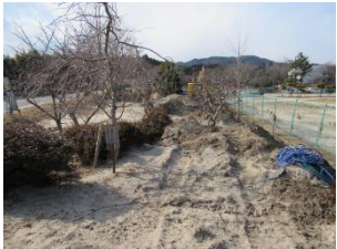
校庭南側の川砂撤去
