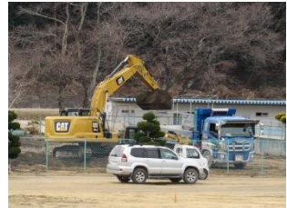
テニスコートの土砂撤去
