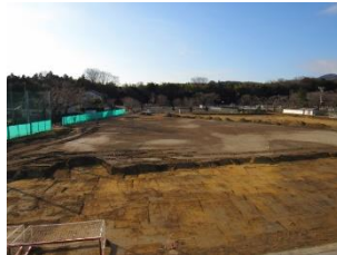
手前は土砂撤去後
