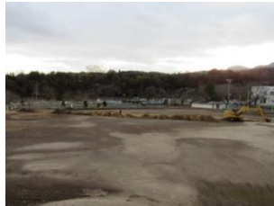
校庭の土砂撤去
