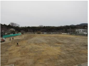
土砂撤去後の校庭
