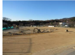
新しい土入れ作業
