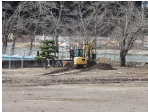
復旧工事の始まり
