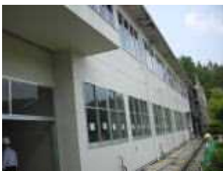
中学校昇降口付近 小学校側に足場設置
