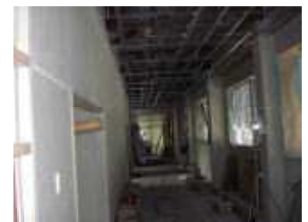
1階はまだ工事中
